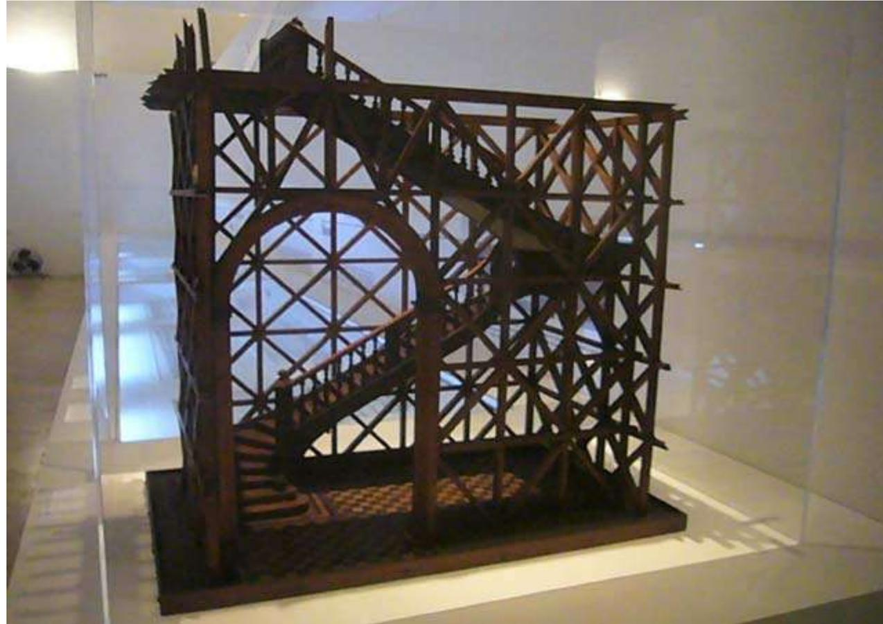
Maquette de la structure en bois antisismique, la « gaiola pombalina » (cage pombaline), développée pour la reconstruction de Lisbonne. Source : Wikipédia
