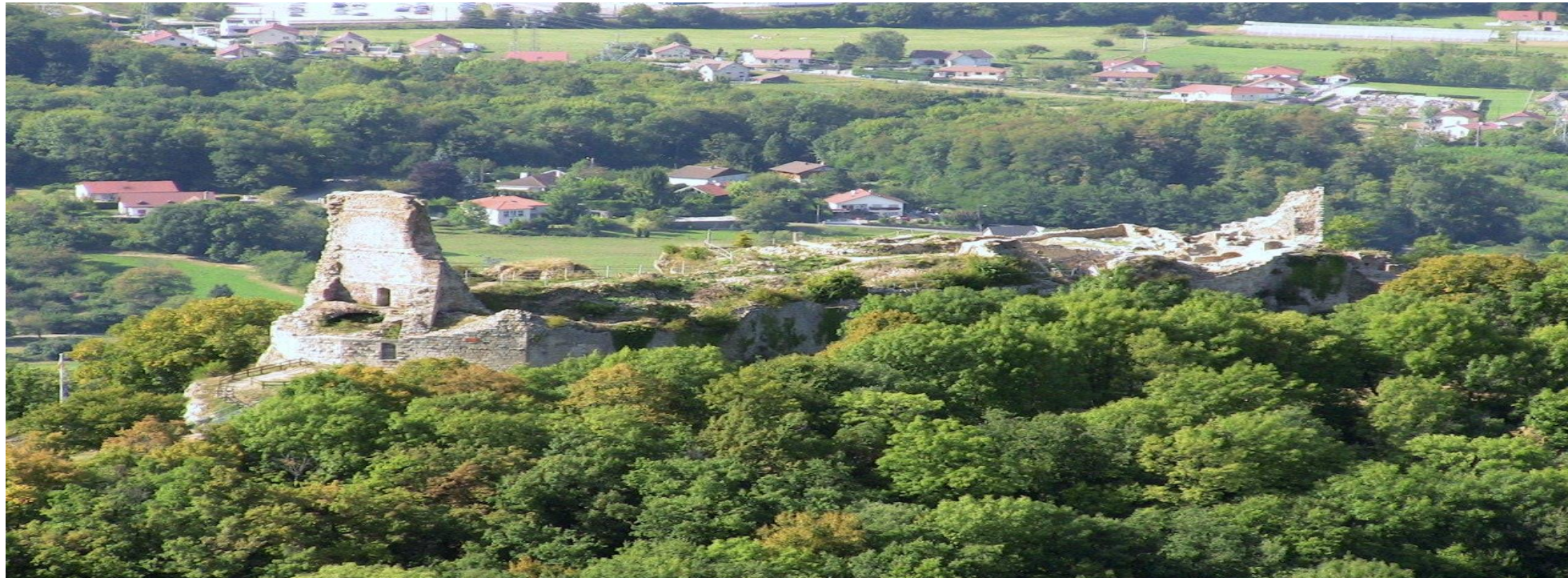
Château féodal de Montfaucon. Source : Wikipédia
