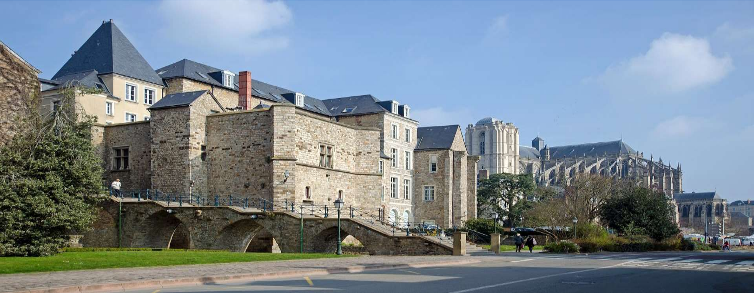
Le palais des Comtes du Maine au Mans. Source : wikipédia
