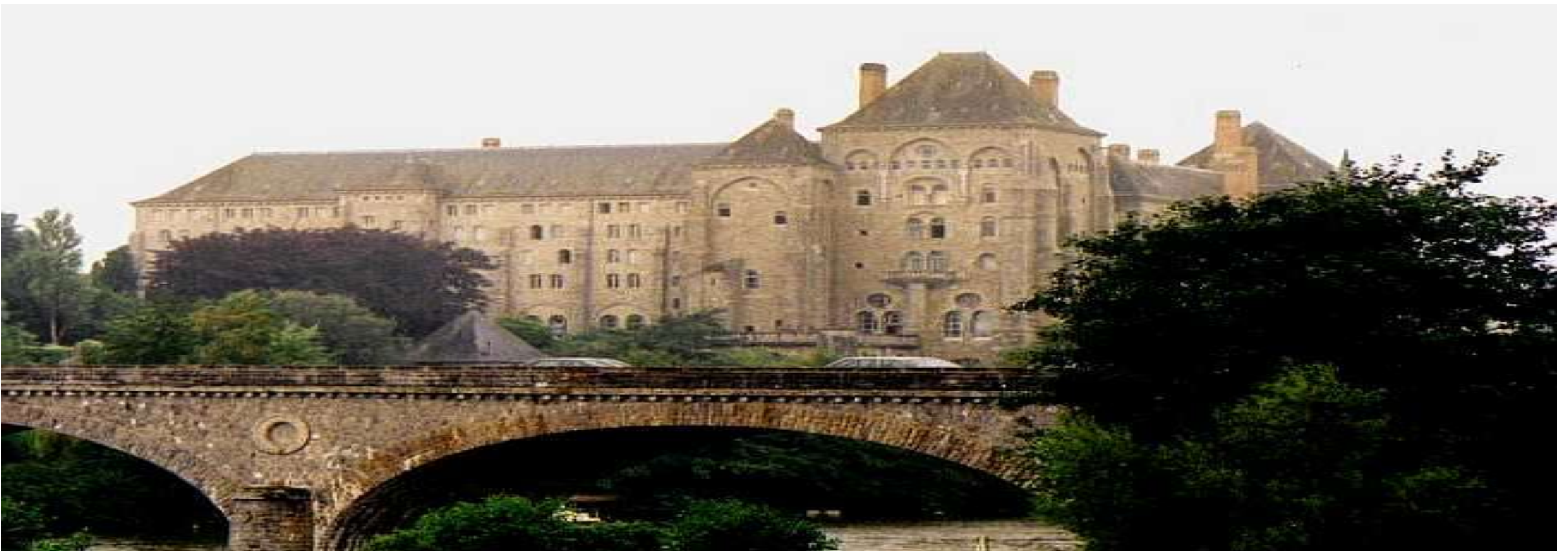
Façade sud-est de l'abbaye de Solesmes. Source : wikipédia
