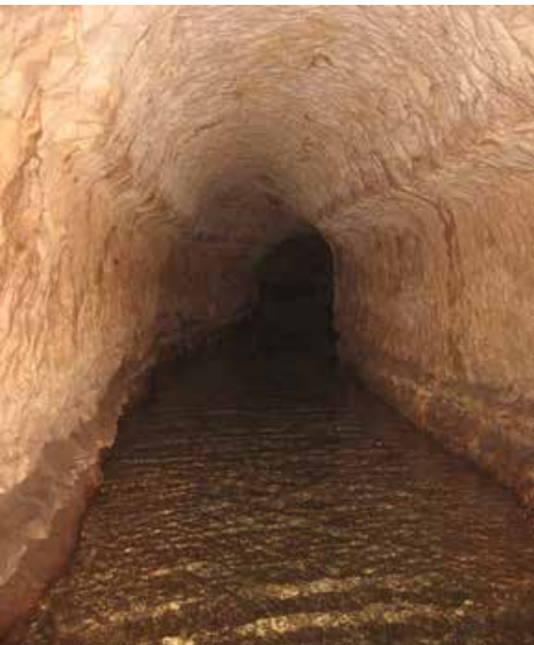
Un tronçon de l'aqueduc.
